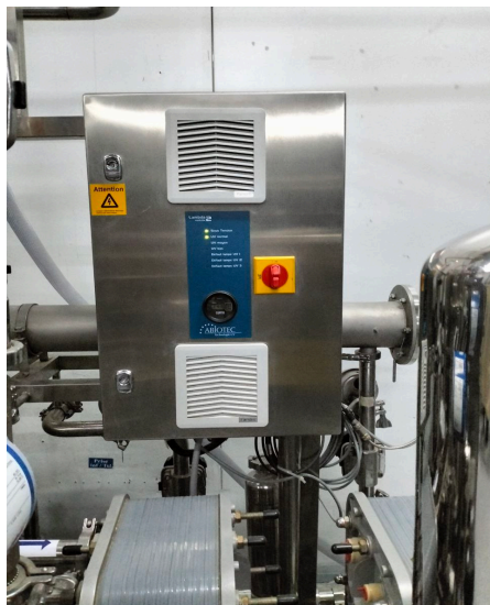
Figure 25 : désinfection par lampe UV.
