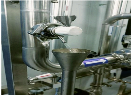
Figure 28 : Purger la vanne pour éliminer l'eau stagnants.
