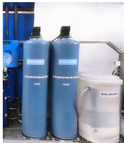
Figure 21 : Adoucisseurs dans la station d'eau chez LDM.
